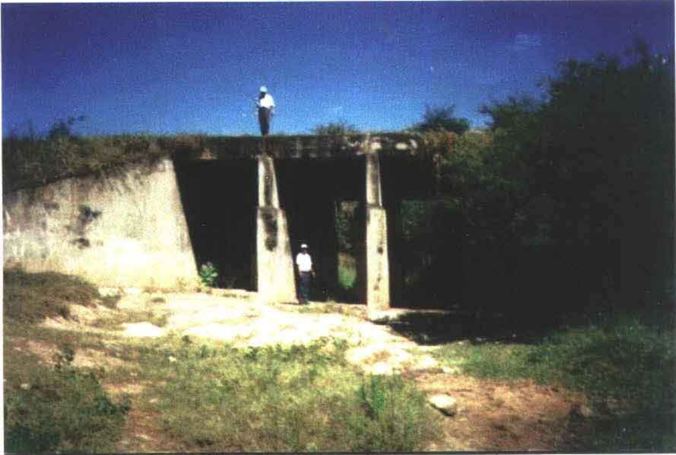
Ponte sob a rodovia CE-481, onde deverá passar a adutora
