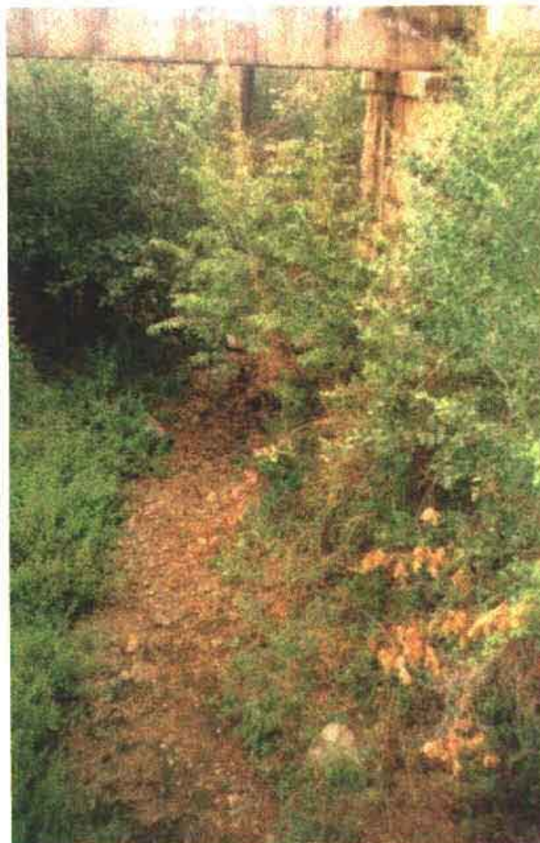
Ponte sob a ferrovia que liga Acopiara a Iguatu, onde deverá passar a adutora
